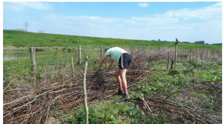
Ril in aanleg met wilgensnoeisels
